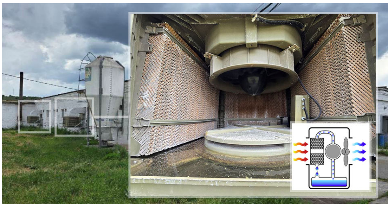
Рис. 3. Система примусового випарного охолодження повітря “Jet Cool” у дослідному приміщенні
